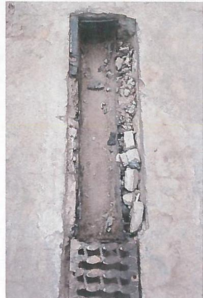
4.3. Предусматривать решения по устройству пристенного дренажа вдоль зданий. Опыт эксплуатации тяжелого достроекного стапеля показал, что отсутствие эффективной дренажной системы приводит к многочисленным негативным последствиям:
